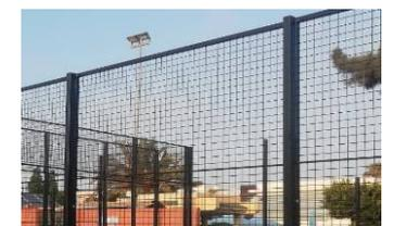
9. Travesaños horizontales en paños de malla electrosoldada mediante perfil hueco rectangular de acero galvanizado de sección 40x30 mm y espesor 1'5 mm, que evitan la deformación de la malla y dan rigidez a la estructura.
