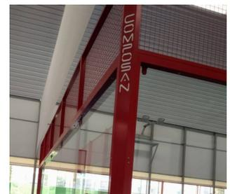
7. Malla electrosoldada galvanizada y lacada al horno de 50x50x4 mm y de dimensiones 995x1992 (±2) mm.
